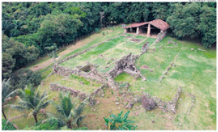
Monumento Nacional Rincão Engenho São Jorge dos Erasmos fica em Santos e foi construído em 1934
